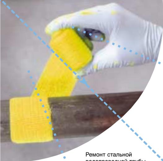
Ремонт стальной водопроводной трубы с помощью комплекта Loctite 5070.
