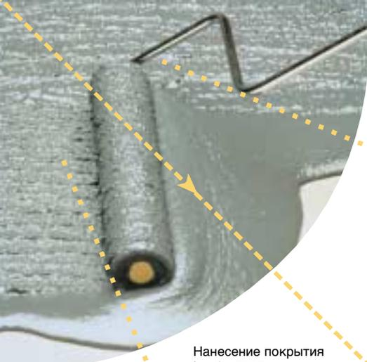
Нанесение покрытия Loctite 7205 на пол производственного помещения с помощью валика
